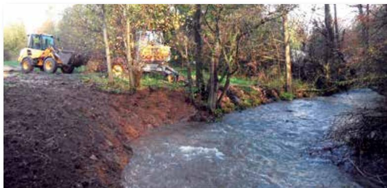
Um einen Anschluss an den vorhandenen Untergrund zu bekommen, wurde das Material im Anschluss mit einer etwa zwei Tonnen schweren Stahlkugel verdichtet. Hierbei war es wichtig, ein gleichmäßiges Sohlgefälle von Ober- nach Unterwasser herzustellen, damit sich später die erforderlichen Wasserstände und Fließgeschwindigkeiten einstellen können.
