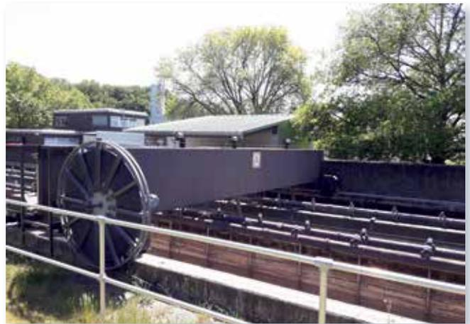
Umfangreichere Überholungsarbeiten an den Laufschiene, den Pumpen und den Räumbrücken erforderten im Laufe des Jahres die sukzessive Außerbetriebnahme der beiden Sandfänge des **KLÄRWERKS SOLINGEN-OHLIGS**.
