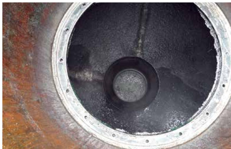
Gleiches gilt auch für das Saugrohr, welches im Rahmen eines Tauchereinsatzes auf Schäden inspiziert wurde und gleichzeitig eine komplett neue Abspannung erhielt.
