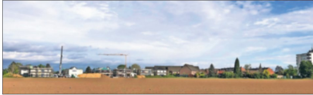
Zwischen dem ersten Bauabschnitt (Foto) und dem dritten/vierten soll es „wirkliche Verbindung“ geben, so dass eine Anbindung an die K 10 in den Augen von Bürgermeister Klaus Krützen keinen Sinn machen würde. Viel Aufwand für eine Handvoll von Neubauten...
