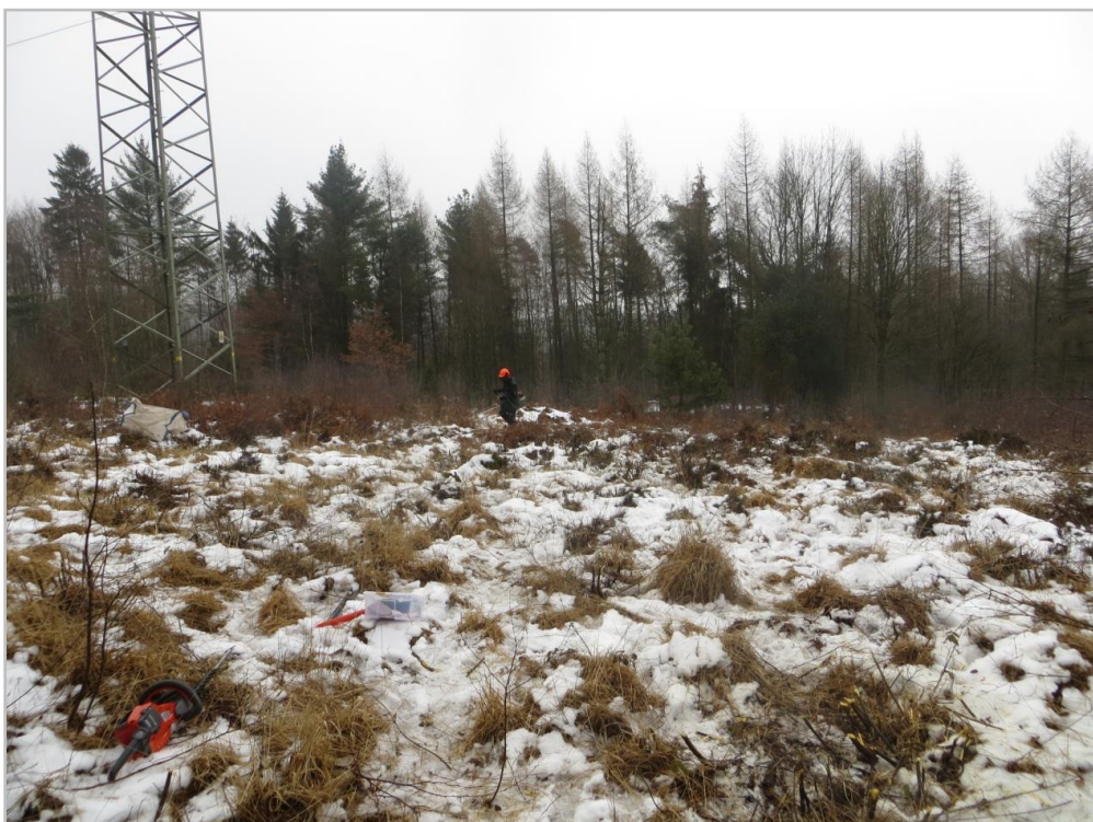
Abb. 61: Freistellungsarbeiten auf der Freileitungstrasse Marscheid (Foto: 05.02.2019, BSMW)
