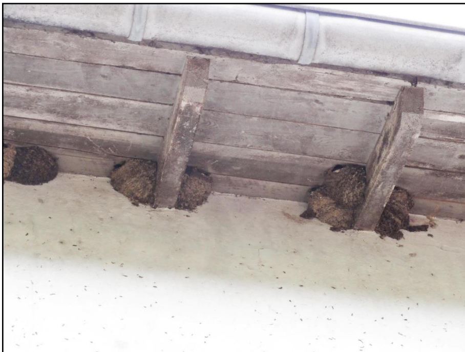
Abb. 8: An der Außenseite eines Rinderstalles in Remscheid-Obergarschagen bildet die Mehlschnalbe mit 67 besetzten Nestern ihre größte derzeit in Remscheid bekannte Brutkolonie. Dicht an dicht reihen sich die Nester unter dem Dachtrauf (Foto: RS-Obergarschagen, 8. August 2018, T. KRÜGER).
