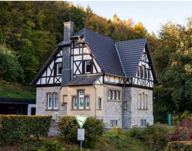
Das rheinische Fachwerk über den Trachyt-Mauern verleiht dem denkmalgeschützten Forsthaus Lohrberg seinen Charakter.
