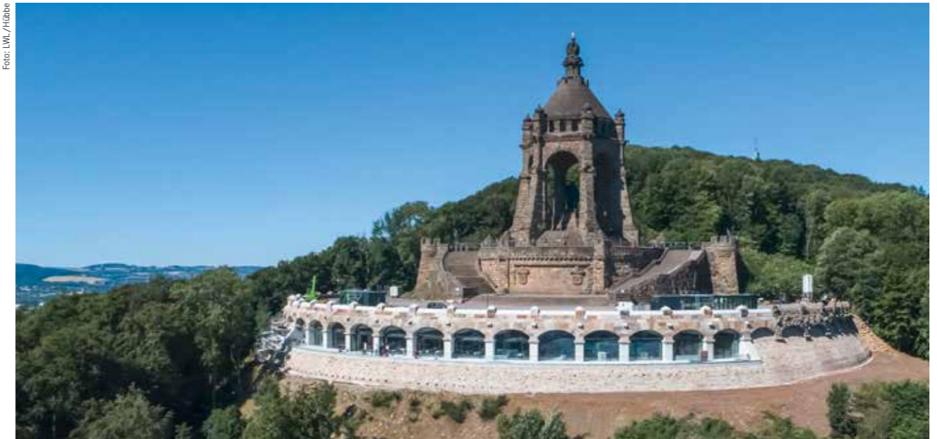
Das Kaiser-Wilhelm-Denkmal an der Porta Westfalica mit der erneuerten Sockelzone. Hinter den Panoramafenstern liegen Besucherzentrum und Gastronomie. Die NRW-Stiftung hat im Rahmen der Restaurierung Maßnahmen zur kindgerechten Gestaltung und der barrierearmen Erschließung gefördert.
