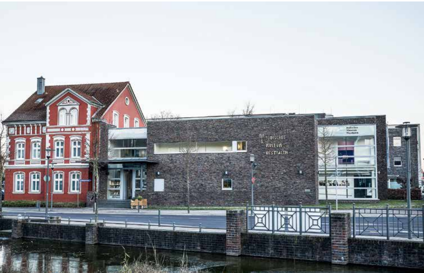
Das Jüdische Museum Westfalen nutzt eine historische Villa (links) sowie seit 2001 einen modernen Anbau.
