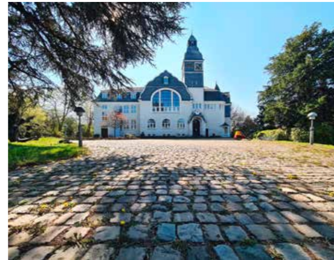
Das Zentrum für verfolgte Künste an der Wuppertaler Straße in Solingen. Foto: Zentrum für verfolgte Künste
