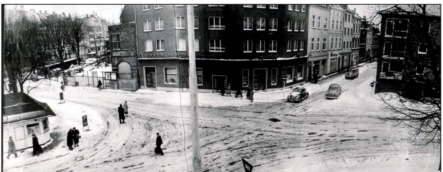
Unten: Ansicht des Drusushofes um 1955, als es offensichtlich noch richtige Winter gab. Der Neubau ist fertiggestellt. Der Anbau, der provisorisch als Verwaltungsgebäude des Theaters genutzt wird, ist noch nicht abgerissen, aber die Vorarbeiten zum Neubau des Theaters haben bereits begonnen. (Foto: Stadtarchiv Neuss)
