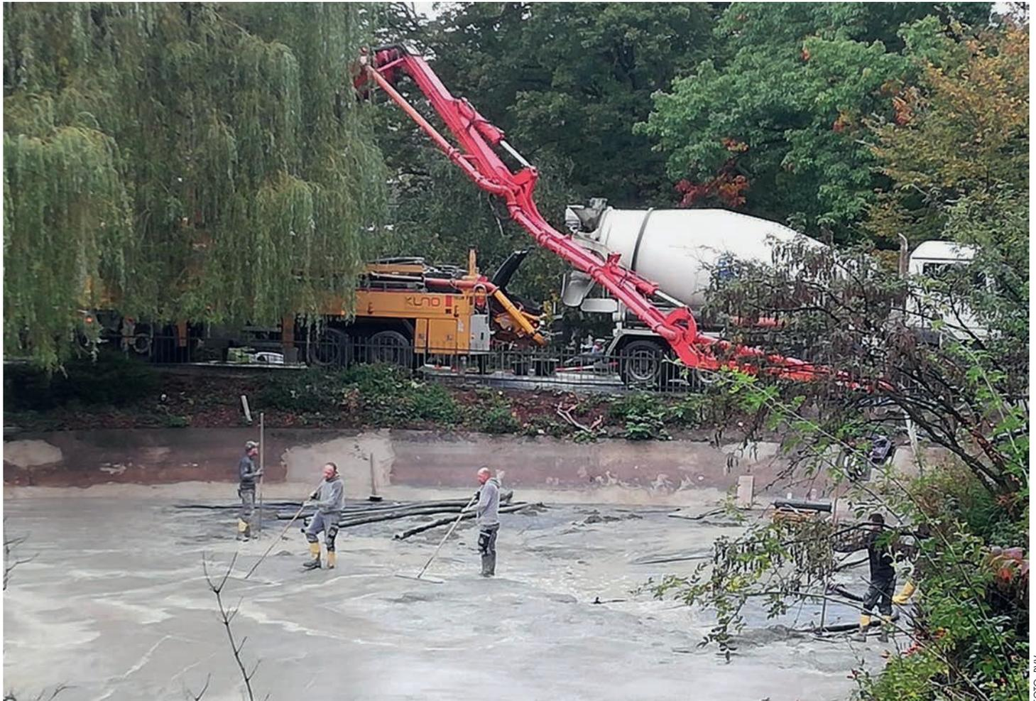
Die Entfernung des Schlammes und das Betonieren des neuen Bodens waren eine große logistische Leistung.
