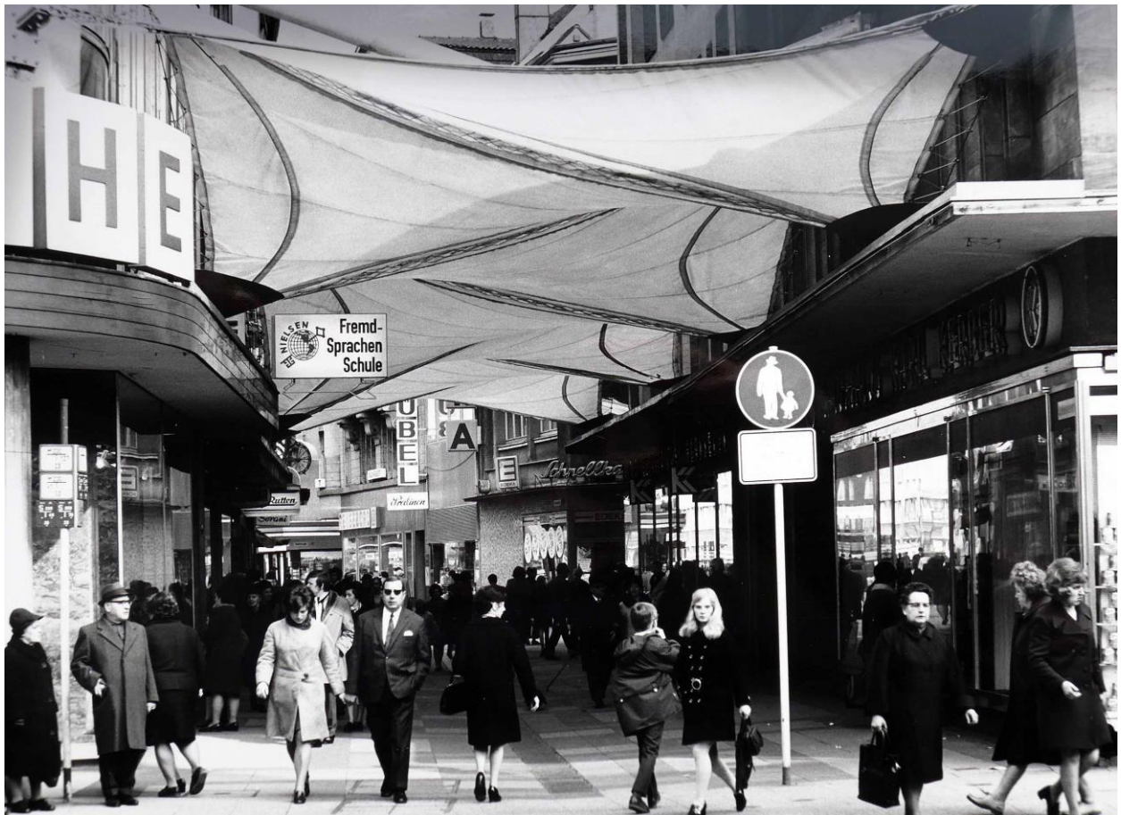
Zeltdach über der Schwanenstraße 1970 bis 1976
