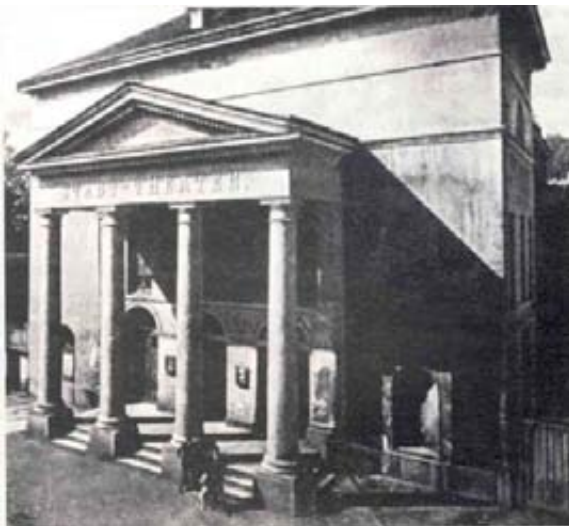
Theaterneubau von 1844 (StArch)
