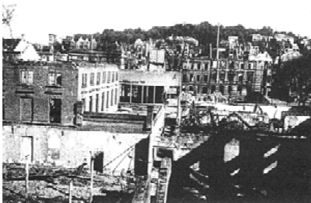
Zerstörte Betriebsgebäude von „Schlieper & Baum“ (StArch.)
