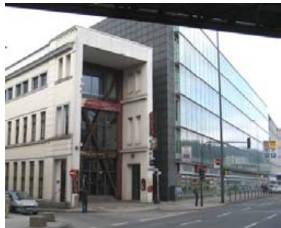
Umgebautes „Textilhaus“ an der Bembergstraße und Neubau an der Bundesallee seit 1999 (H. Heyken)
