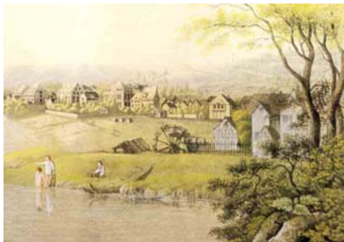
Kaufmannshäuser an Hofaue und Bandfabrik Bockmühl um 1810
