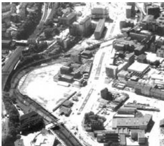
Bundesallee und ehem. „Schlieper & Baum“ 1961 (Luftaufnahme Vermessungs- u. Katasteramt)
