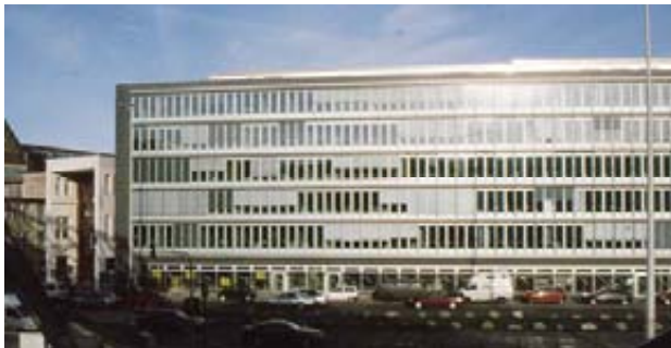
Das neue ADAC-Bürogebäude entlang der Bundesallee (Foto H. Heyken 2010)
