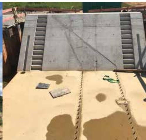
Wehr mit vorbereiteter Verankerung für Schlauchkörper
