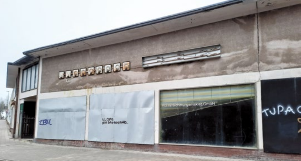
Seit Jahren ist das alte Möbelhaus ein Schandfleck im Lenneper Stadtbild.
