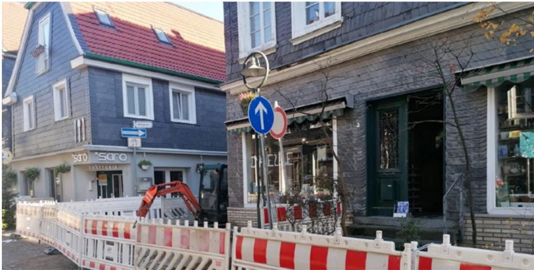
In der Mühlenstraße bereiten die Fußplatten am Rand immer wieder Ärger, weil sie von Autos beschädigt werden. Deshalb wird diese Dauerbaustelle jetzt noch mal angepackt. Kleinere Natursteine sollen eine längerfristige Lösung bieten.
