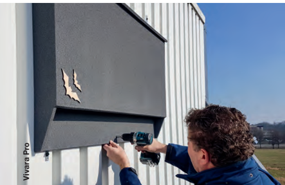
Fledermausquartiere und andere Nisthilfen können auch an gewerblich genutzten Gebäuden nachträglich angebracht werden.
