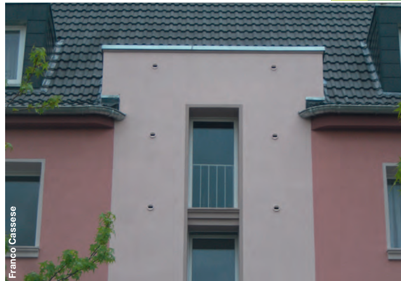
Nachher: Die kleinen Einfluglöcher für Mauersegler sind in der sanierten Fassade kaum zu erkennen.
