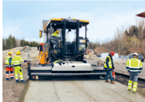
Betoneinbau mit dem Volvo-Kettenfertiger: Die Einbaubreite entspricht der Breite des Geräts.
