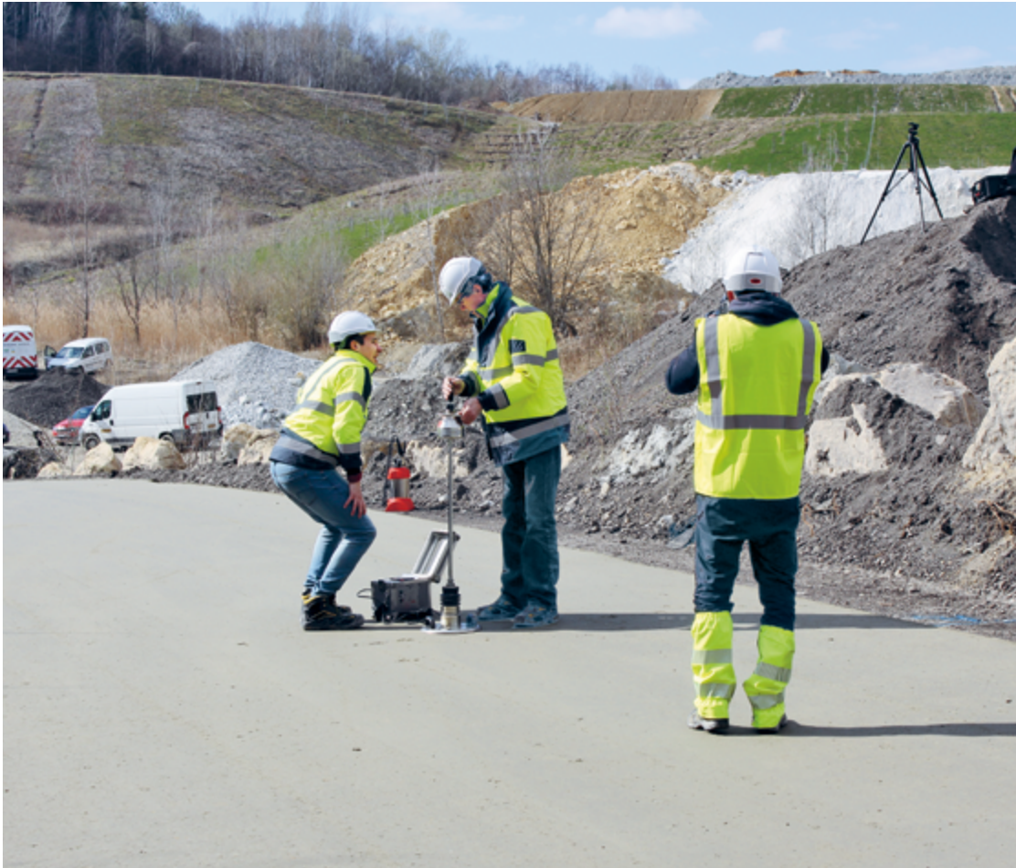
Die Einbaukontrolle erfolgte sowohl durch begleitende Frischbetonprüfungen als auch durch Verdichtungskontrolle mit zerstörungsfreier Messung der Raumdichte mittels Troxlersonde sowie mittels leichten Fallgewichtsdeflectometers.
