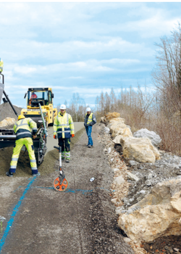
Einbauvorgang mit dem Kettenfertiger, im Hintergrund die Nachverdichtung mit der Walze
