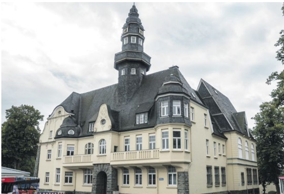
Das hintere Umfeld des Lüttringhauser Rathauses wird neu gestaltet.
