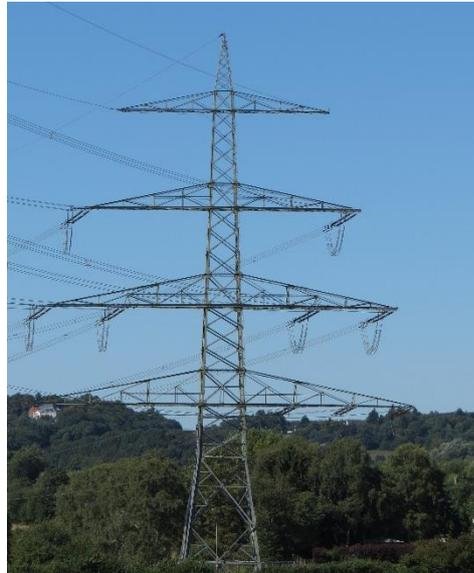
Abbildung 2-7: Winkelabspannmast;
