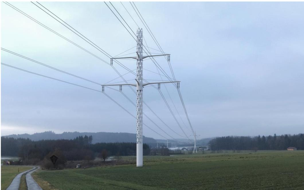
Abbildung 4-20: Gitterstrukturrohr zylindrisch mit schmalem Mast
