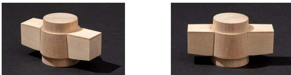
Abbildung 5-6: Modell der aufgesteckten Traverse
