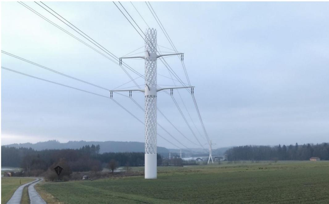
Abbildung 4-21: Gitterstrukturrohr zylindrisch mit breiterem Mast
