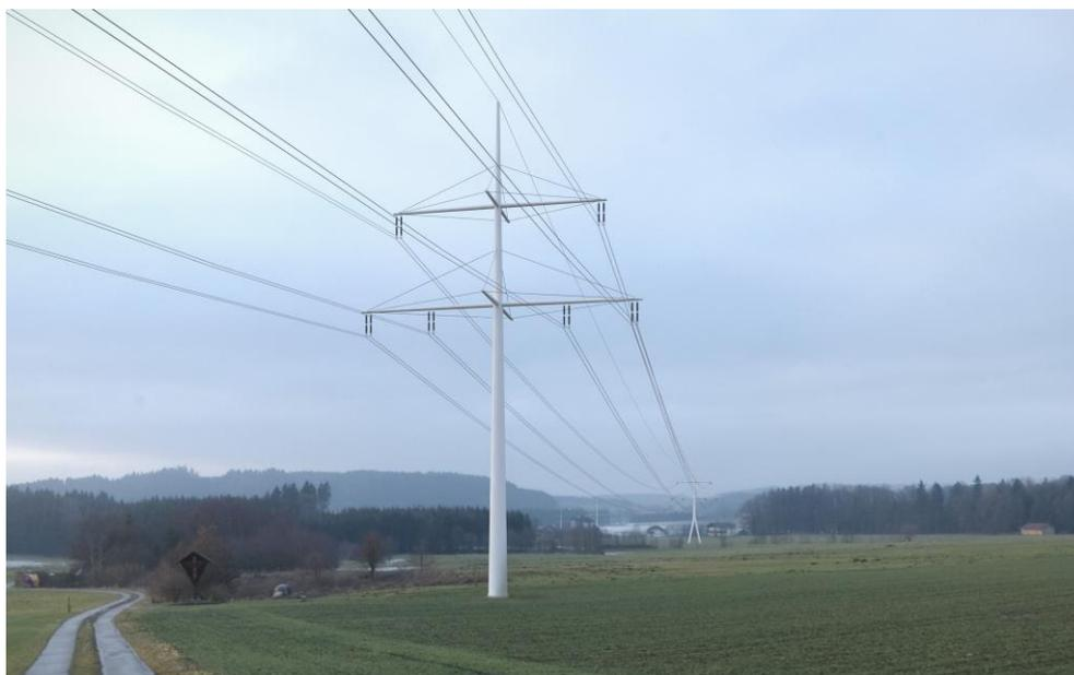
Abbildung 4-17: Mast mit Vollwandrohr konisch und Traverse abgespannt
