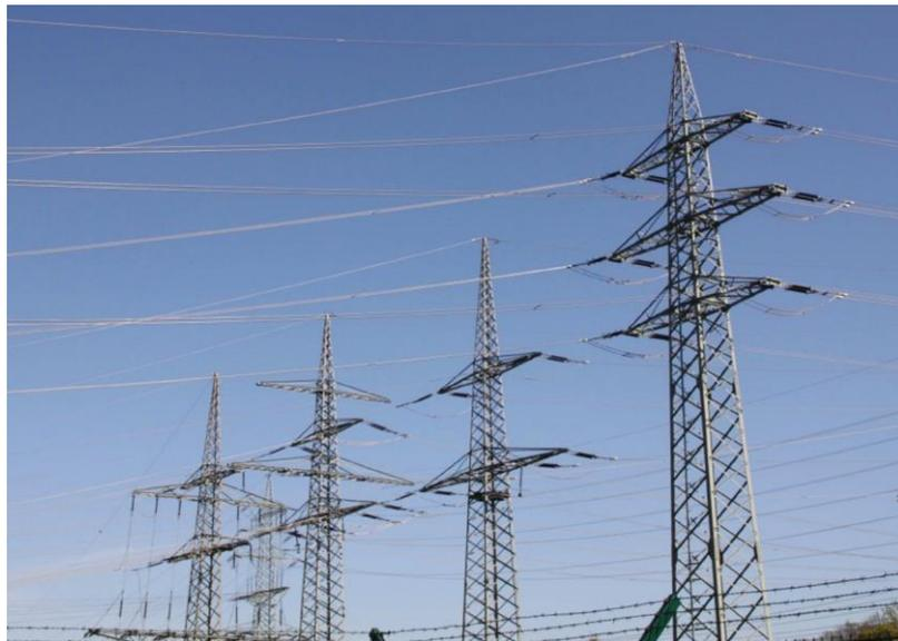
Abbildung 2-10: Mehrere Endmasten vor einem Umspannwerk (links, nicht im Bild)
