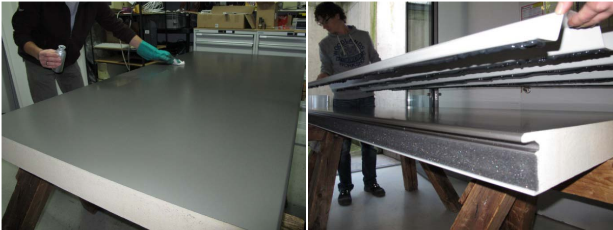
Abbildungen 5-6: Bau von SEA 2.1: Grundieren des Sandwichelements und Aufsetzen sowie Verkleben des Absorbers mit dem Sandwichelement
