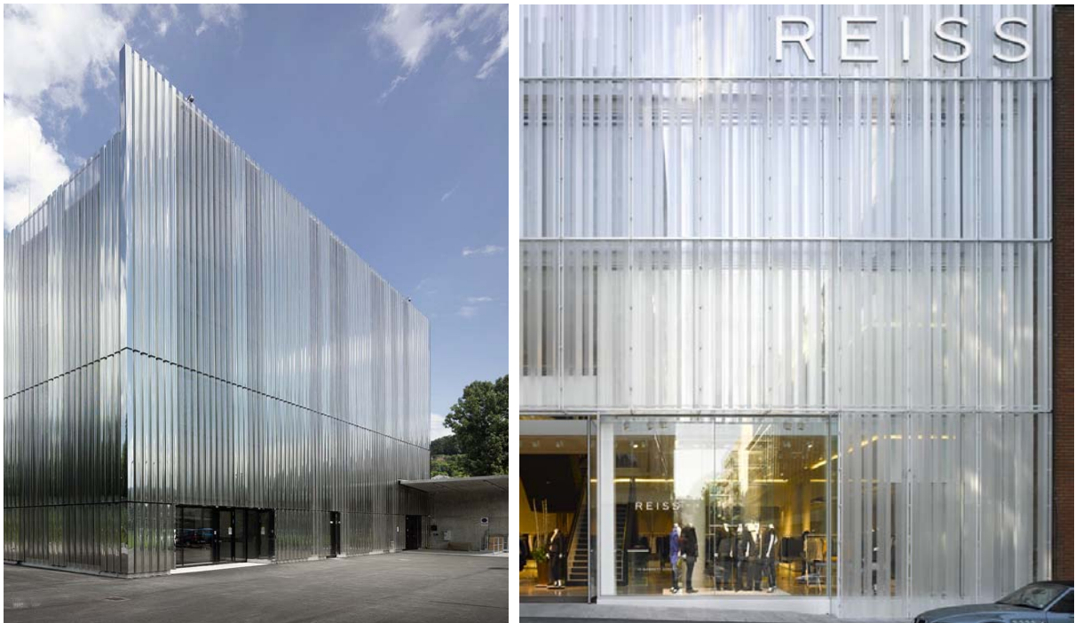
Abbildung 8-5: Beispielfotos aus der Präsentation von FACADE-LAB zu den architektonischen Gestaltungsmöglichkeiten mit SEA-ähnlichen Fassaden, links: Data Storage Center, Basel, Schweiz, Arch.: FFBK Architect; rechts: REISS Headquarter, London, UK, Arch.: Squire & Partners
