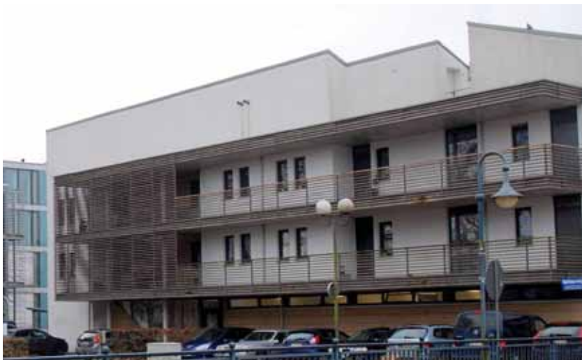
Blick vom Balfourweg auf das Haus der Diakonie
