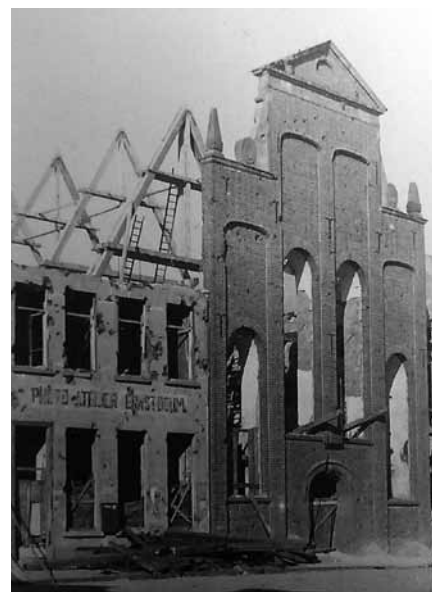
Beginn des Wiederaufbaus der kriegszerstörten Kirche zu Beginn der 50er Jahre
