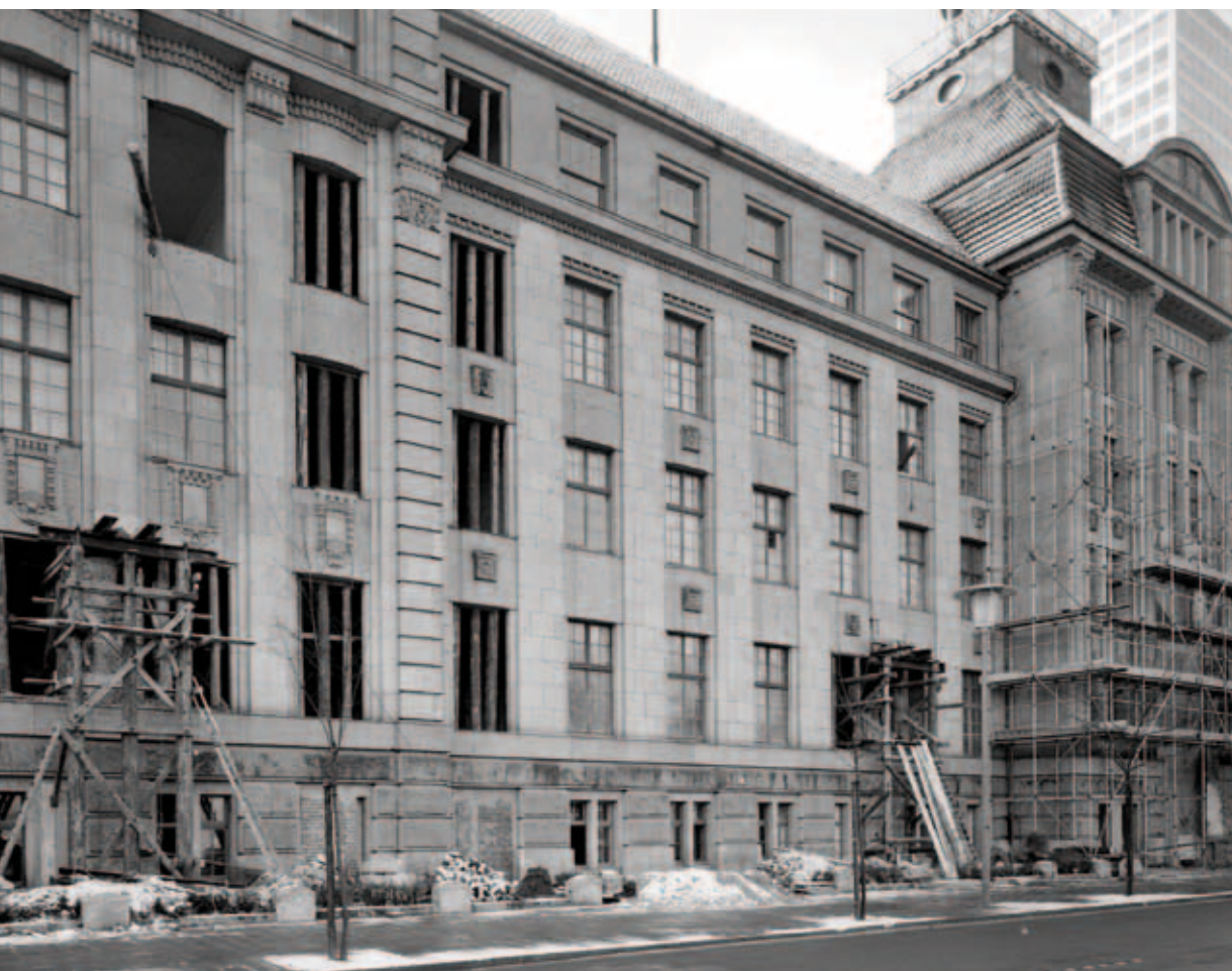
Grundsaniierung des Landeshauses, um 1960
