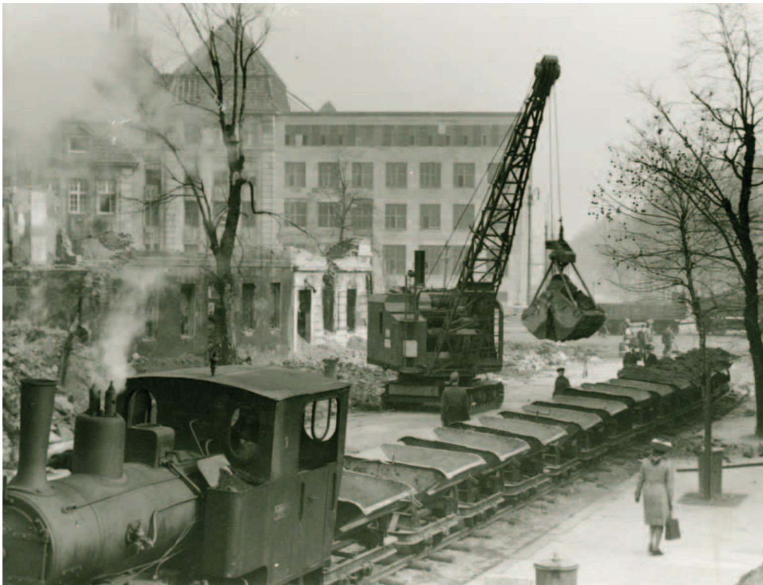
Trümmerräumung 1945, im Hintergrund das Landeshaus
