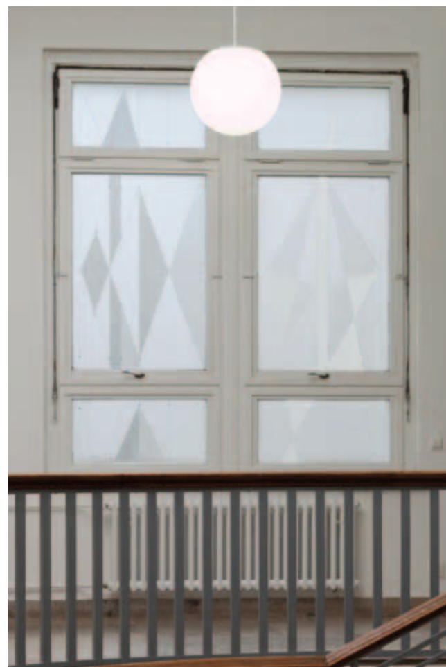
Glasfenster von Ludwig Gies (1961) im Treppenhaus des Landeshauses, 2009
