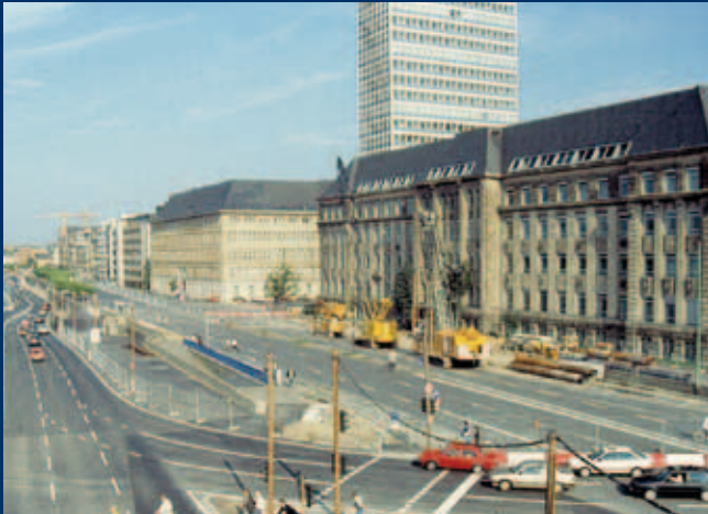
Beginn der Bauarbeiten am Rheinfertunnel, 1990
