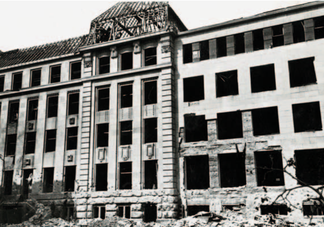
Kriegsschäden am Landeshaus, 1944
