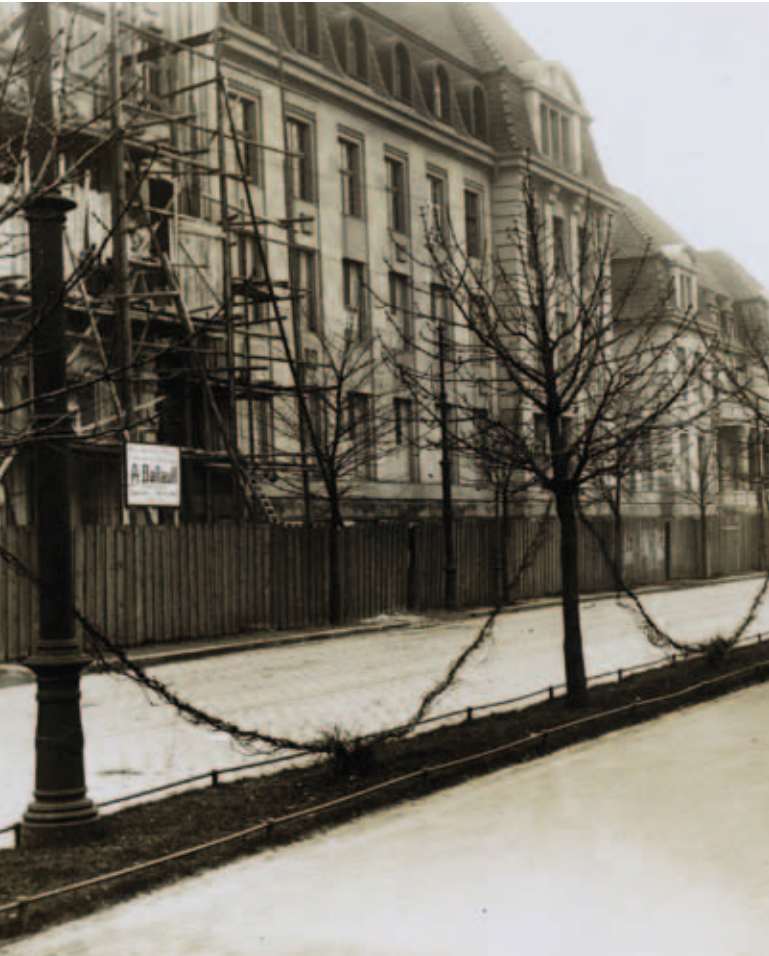
Letzte Arbeiten am Landeshaus mit Baustellenschild der Firma Ballauff, 1911
