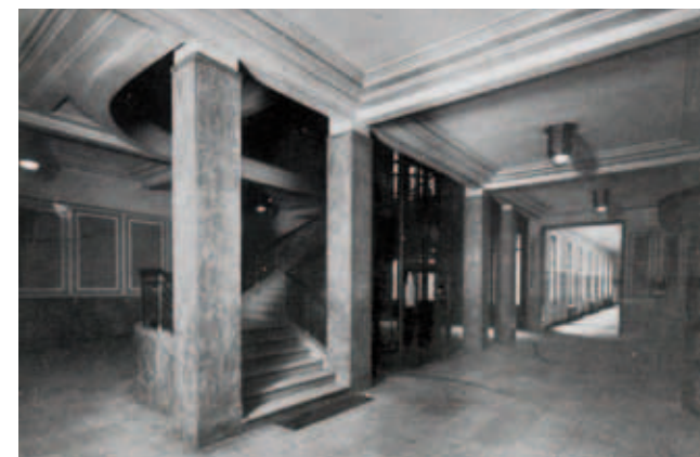
Treppenhaus des Landeshauses, um 1920
