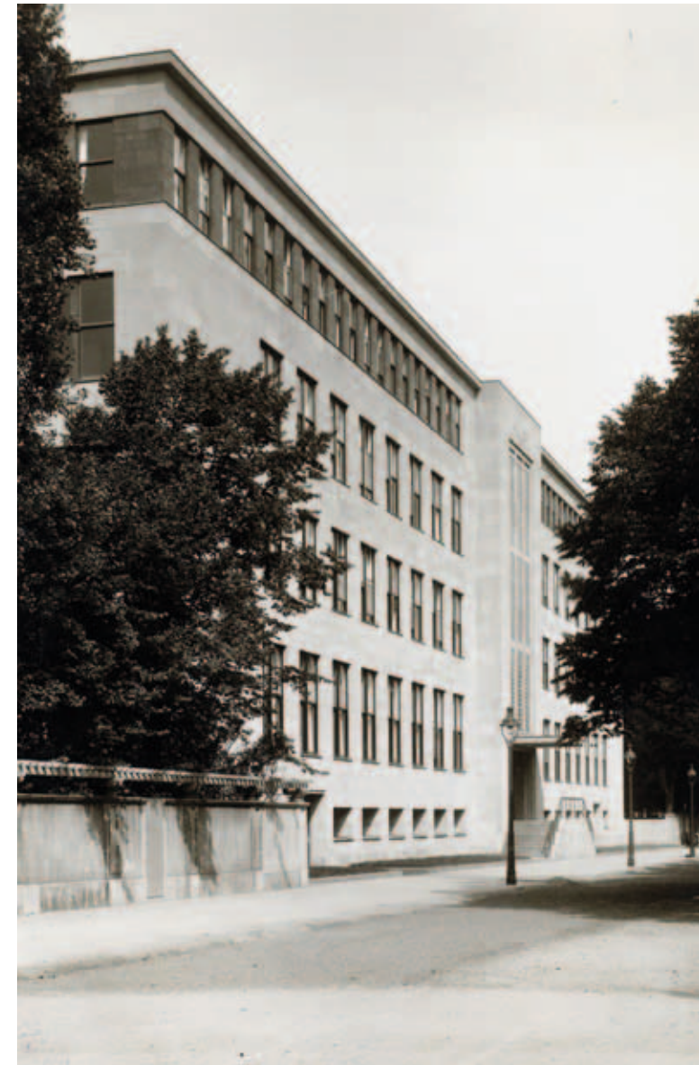
„Rühl'scher Anbau“ des Landeshauses an der Berger Allee, 1933
