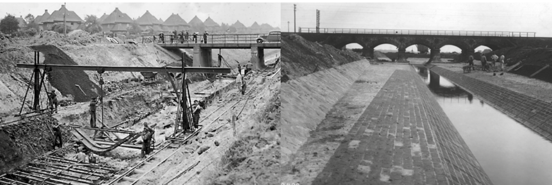
Ein Verlegegerüst für Emschersohlschalen am Landwehrbach, ca. 1929
