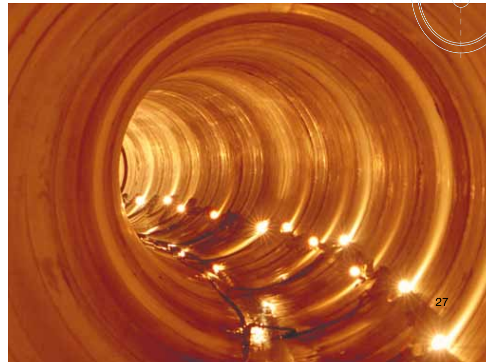
Kanal am Oberlauf der Emscher kurz vor Holzwickede
