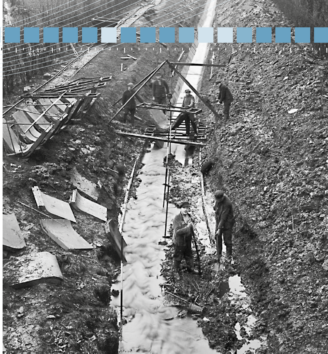
Der Marbach bei der Verlegung von Sohlschalen
