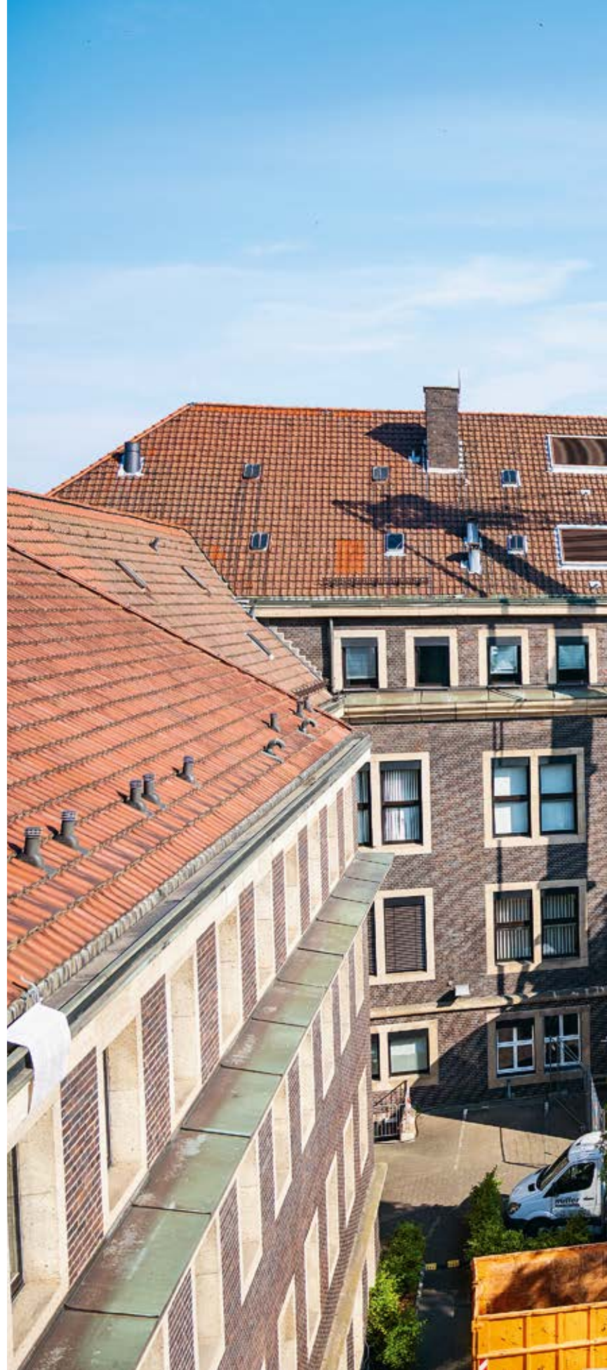
Blick in den Innenhof der Hauptverwaltung in Essen während der Sanierungsarbeiten
