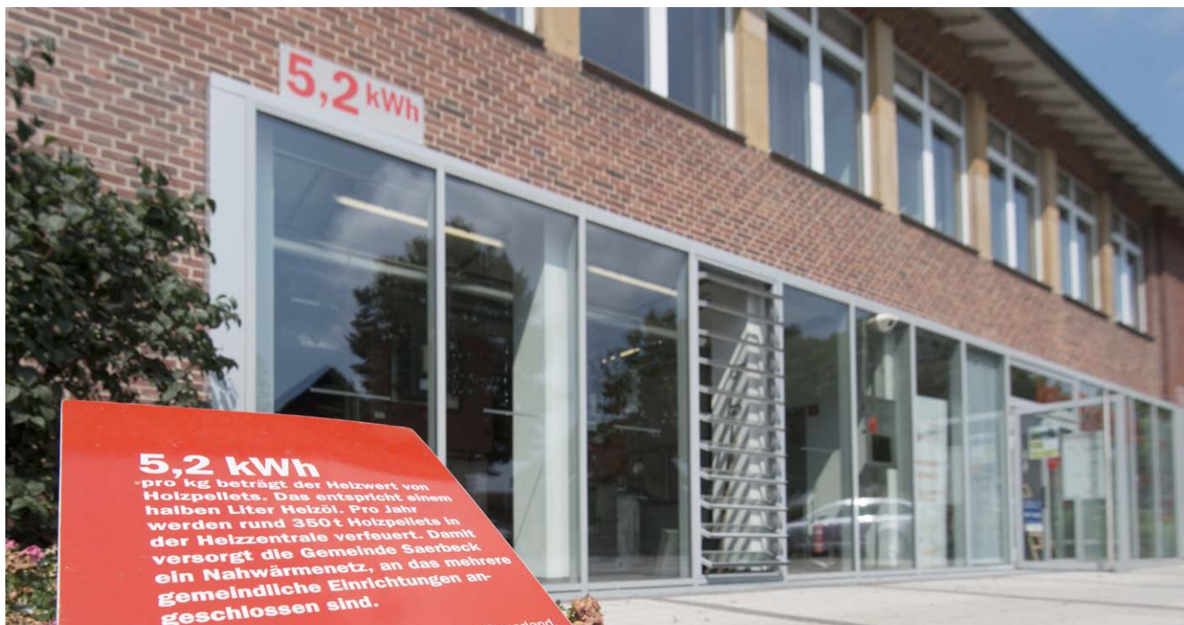
Abb. 60: Gläserne Heizzentrale mit Informationen zum Klimaschutz in der Innenstadt Saerbecks
