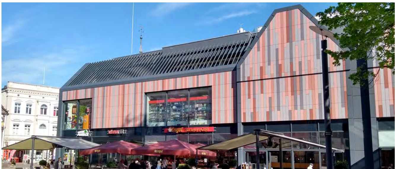
Abb. 114: „Markt 1“ - Fassade nach Umbau
