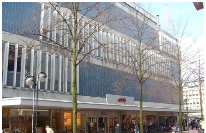
Abb. 15: Ehemalige Hertie-Immobilie vor dem Umbau
