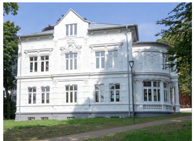
Abb. 128: Villa Wippermann in Halver nach der Sanierung
