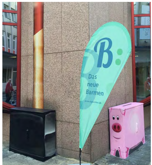
Abb. 10: Umgestaltung von Verteilerkästen
