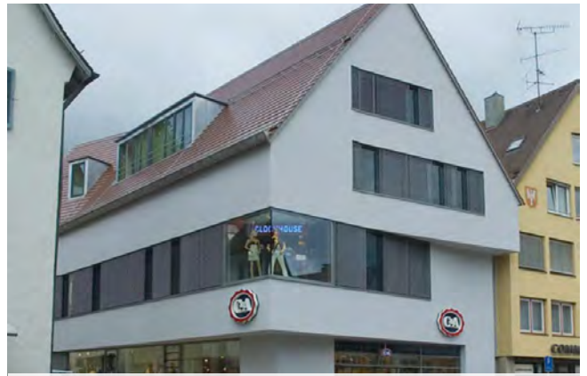
Abb. 19: Neubau am Marktplatz
