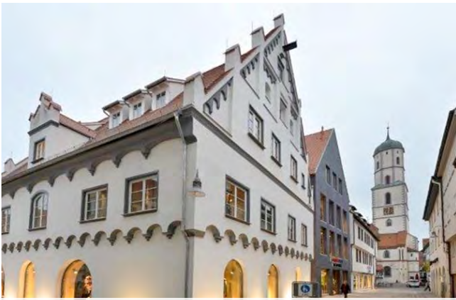
Abb. 18: Beispiel für einen Umbau
