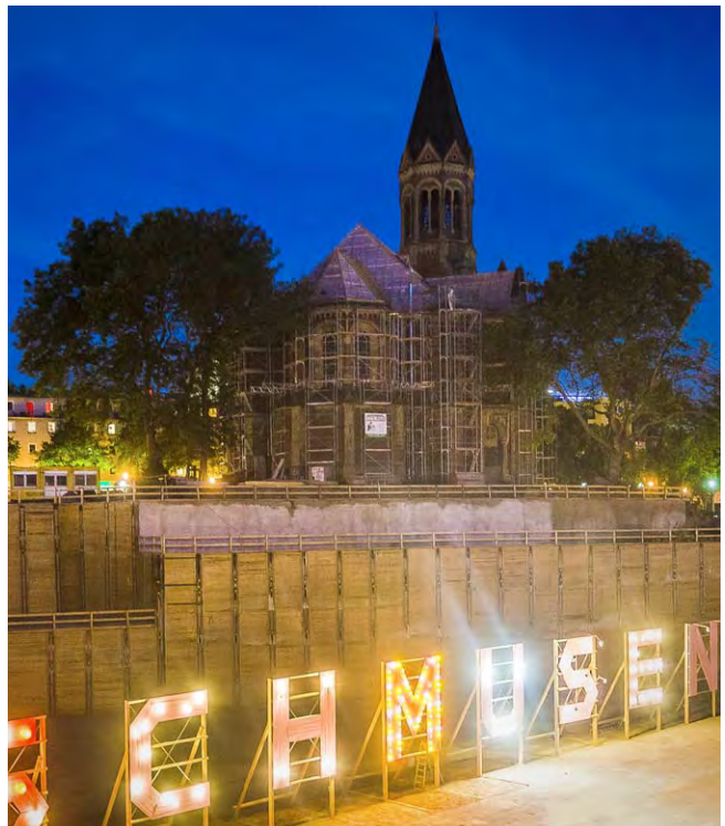
Abb. 39: Bespielung der Baustelle
