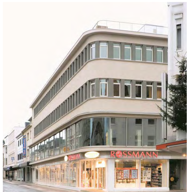
Abb. 47: Eschweiler Kaufhaus Breuer nach dem Umbau
