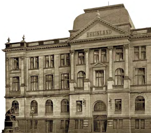
Abb. 43: Neusser Rheinlandgebäude vor dem Umbau
