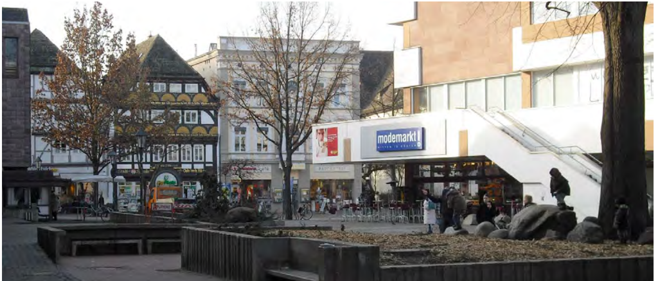
Abb. 113: Ehemaliges Hertie-Haus und Marktplatz vor Umbau
