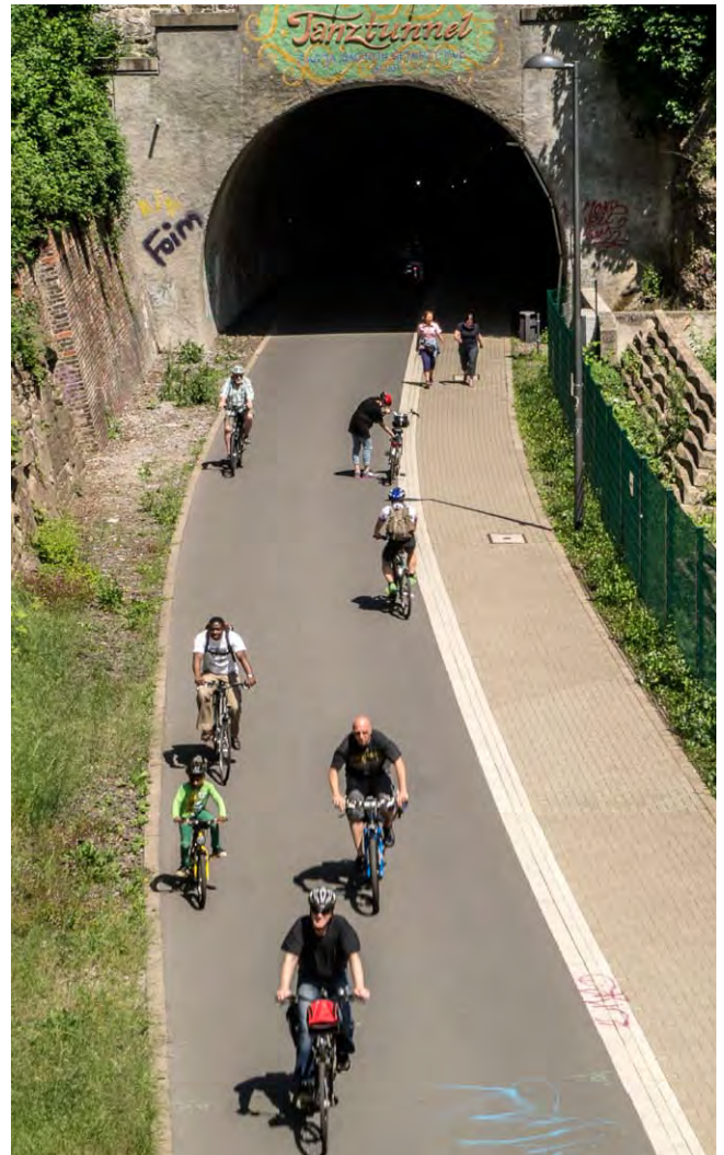
Abb. 72: Bauwerke wie Tunnel auf dem Weg der Trasse
