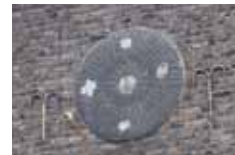
Der Mühlstein in der zur Hafensstraße weisenden Fassade der Traufseite
