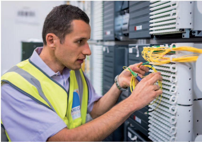
Auch die Glasfasertechnik der MEGA wurde am 5. April erläutert. Hier schließt Mitarbeiter Daniel Neumann einen Router an. Foto: MEGA/Tim Koegler
