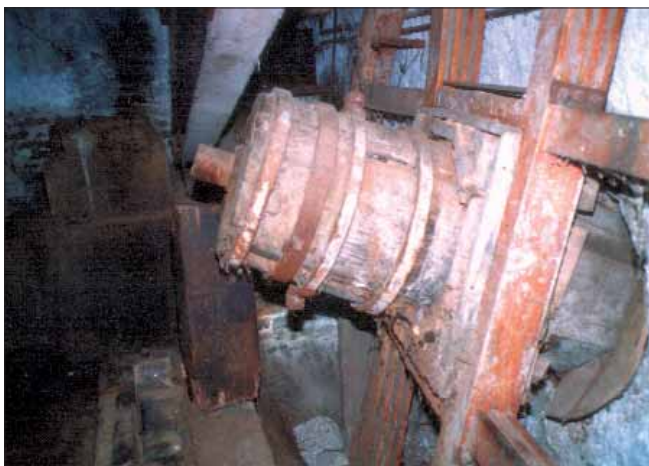
Bild 9: Im Mühlengebäude vorhandener Rest der Wasserradwelle. Rechts im Bild: Endstück der 8-kantigen Welle.
