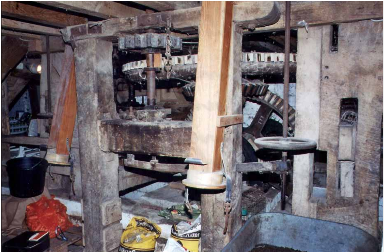
Bild 1: Antrieb Schrotgang (NiG2); oben: Zahnrad auf dem Mühlleisen mit Spurzapfenlager auf Spurbalken mit Stellspindel.
