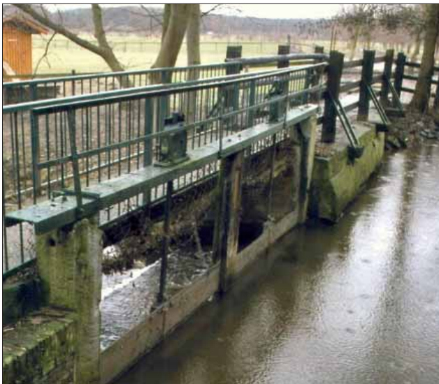
Bild 18: Freischütze im Oberwasser.
