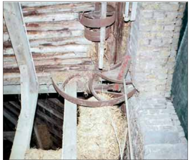
Bild 20: Transmission für den Antrieb außerhalb der Mühle.
