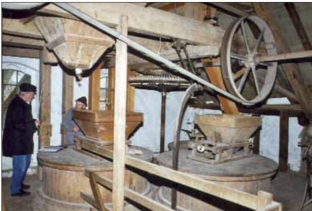
Bild 8: links: Roggengang (NiG1); hinten rechts: Weizenmahlgang (NiG3).
