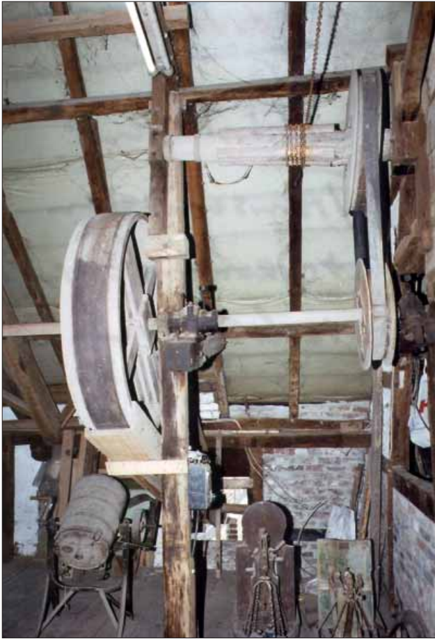
Bild 6: Transmission und Sackaufzug.
