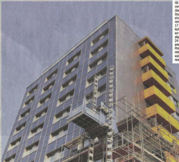
Die Fassade an der Südseite des Studentenwohnheims an der Veleddastraße wurde fast komplett mit einer Photovoltaik-Anlage verkleidet. Der Energieertrag wird ins Stromnetz eingespeist. Bis die Anlage Erträge abwirft, können aber bis zu 30 Jahre vergehen. Fotos: Walter Buchholz
