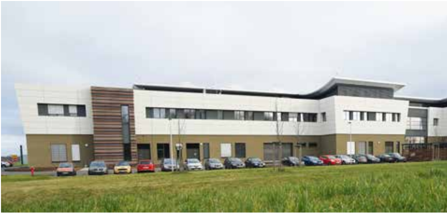
Die Halle C22 ist ein echter Hingucker auf dem Fliegerhorst in Nörvenich. Die Fassade kaschiert geschickt die unterschiedliche Geschosshöhe der ebenerdigen Werkstätten und der darüberliegenden Räume.
