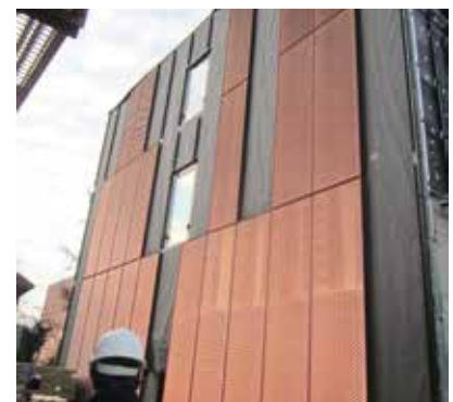
Die grobmaschigen Streckmetall-Elemente aus Kupfer, die am Neubau montiert wurden, prägen die Optik der charakteristischen Fassade des Bottroper Campus-Gebäudes.
