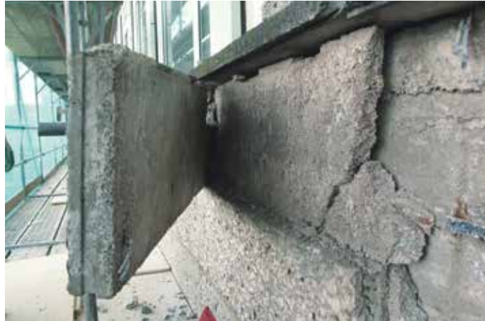
Einige Fassadenplatten mussten gelöst werden, um die Fassade wieder hübsch und sicher zu machen
