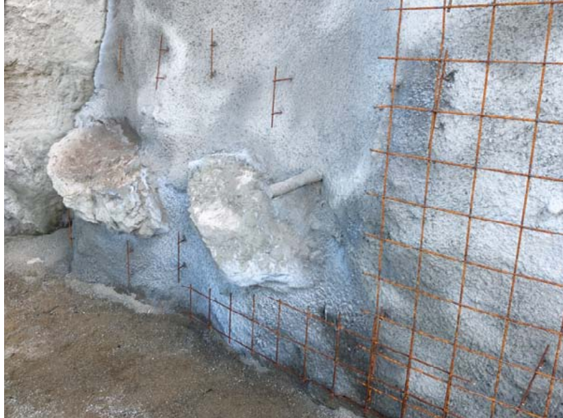
Spritzbeton mit Bewehrung
