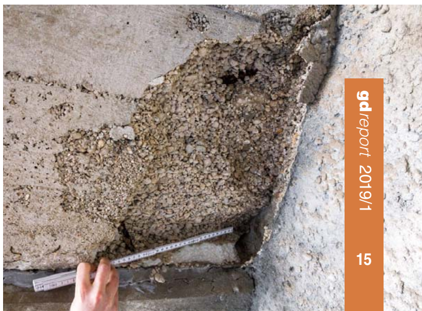
Kiesnest an der Unterseite eines Gurtbalkens
