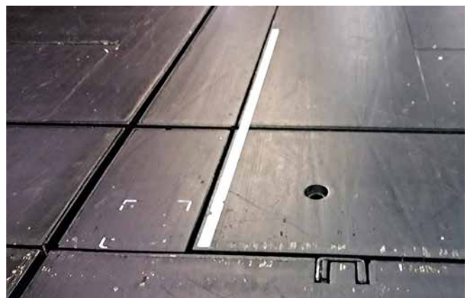
Akute und chronische Verletzungsgefahren durch fehlenden Schwingboden und (links) unterschiedliche Härtegrade sowie (rechts) Aufspaltung und Drehbühnenspalt
