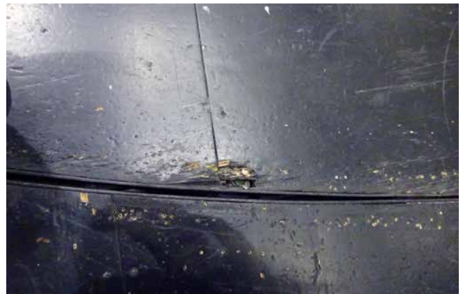
Akute und chronische Verletzungsgefahren durch fehlenden Schwingboden und (links) unterschiedliche Härtegrade sowie (rechts) Aufspaltung und Drehbühnenspalt
