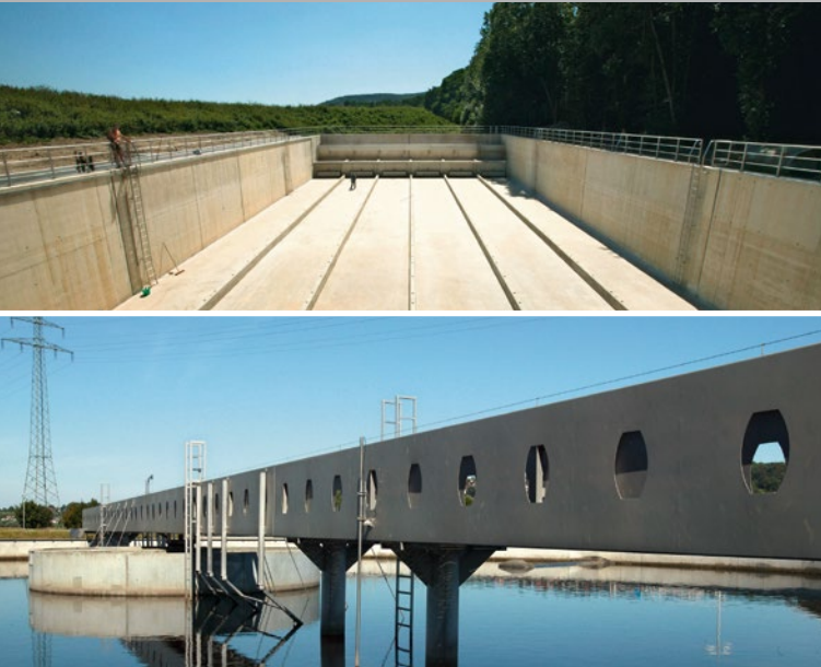
Regenbecken (oben) und Kläranlagen (unten) sorgen für sauberes Wasser.
