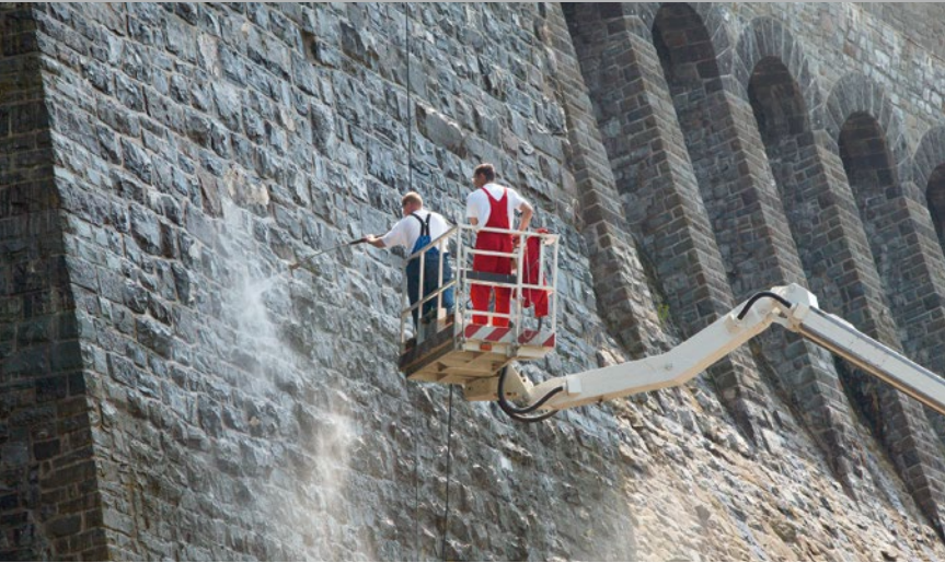
Reinigung der Mauerwerksflächen an der Möhnetalsperre.
