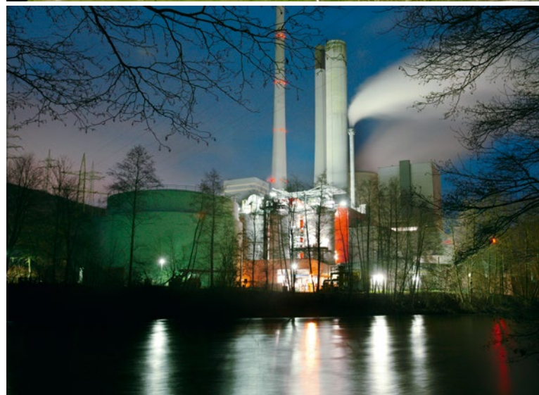
Oben: Kläranlage Duisburg-Kaßlerfeld, unten: Schlammverbrennungsanlage Elverlingsen.
