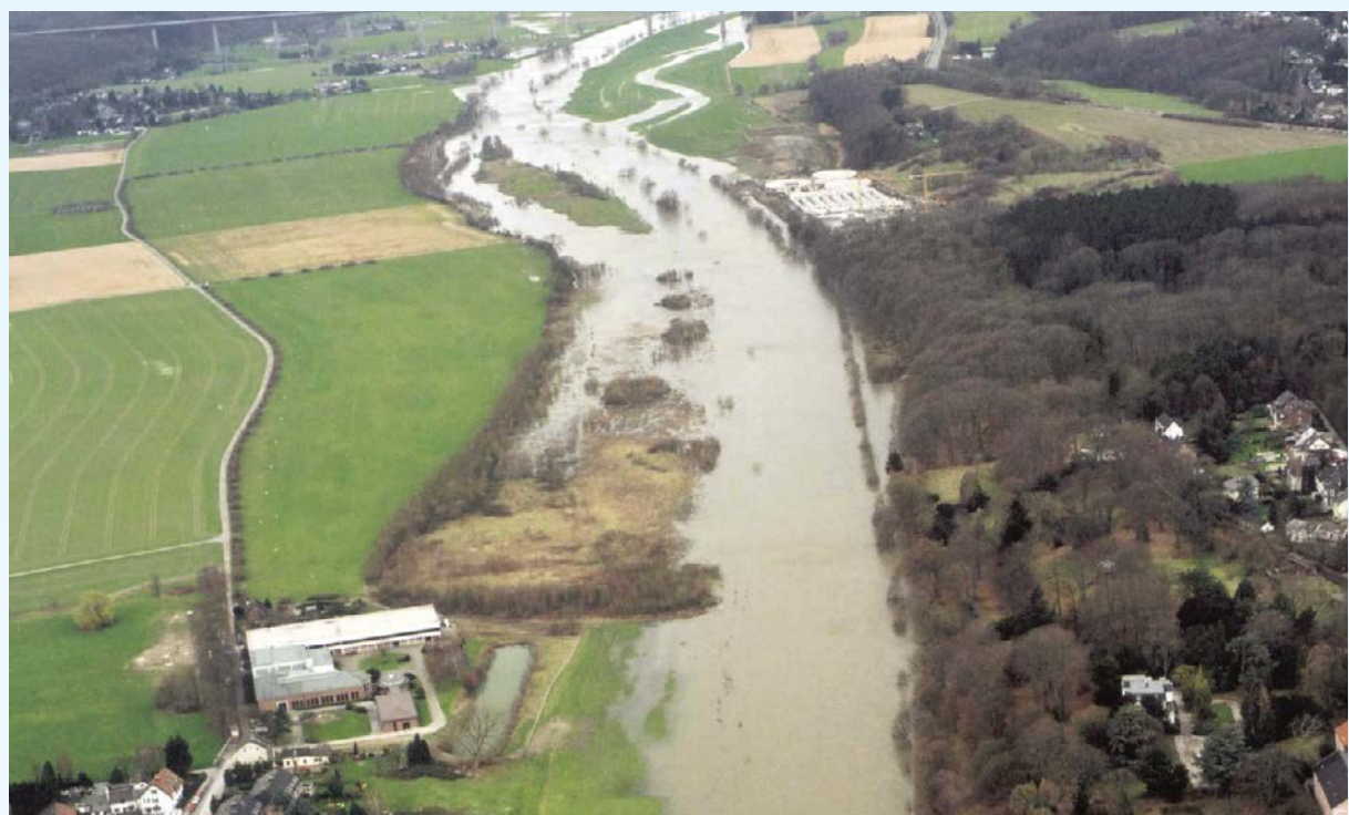
Abbildung 18 und 19: Beispiel für die Anpassung der RWW an Extremereignisse: unterirdische Dichtwand in Essen-Kettwig zum Schutz vor Überflutung des Wassergewinnungsgeländes.
