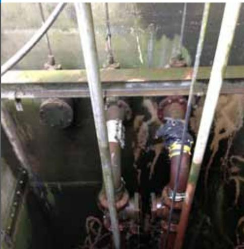
unter anderem eine TV-Untersuchung der Beschickungsleitung vorgenommen. Es wurde festgestellt, dass die Stahlleitung unterhalb der Beckensohle aufgrund des Alters verschlissen war. Durch die abrasiven Inhaltsstoffe des Abwassers (Sande) war die Rohrsohle an einigen Stellen zum Teil vollständig durchgeschliffen.
