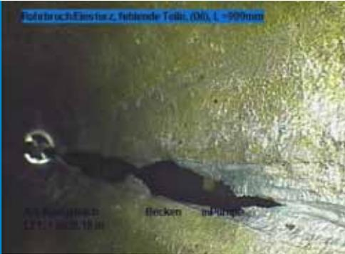
Betriebsstelle Kaldenkirchen: Schadstelle an der Rohrleitung durch Abrasion
