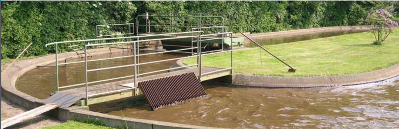
Alte Kläranlage Wetten
