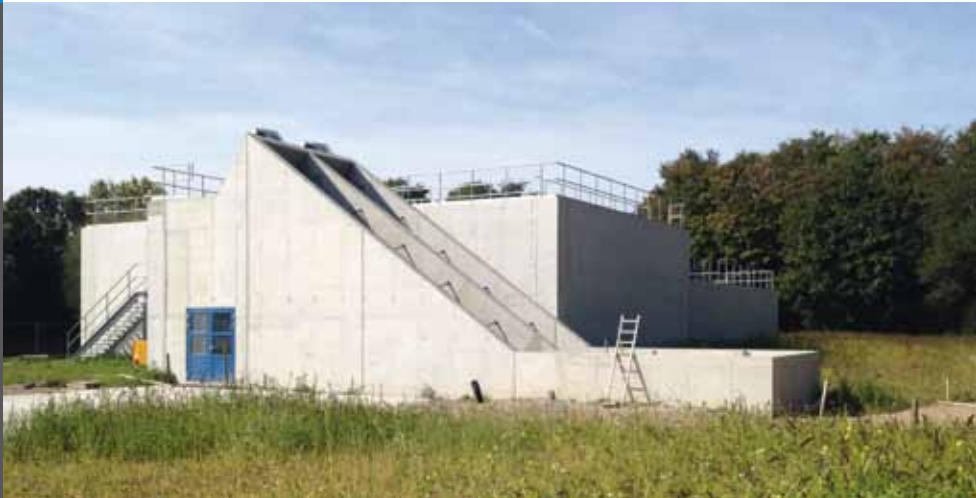
Neuer Flockungsfilter auf der Kläranlage Dülken
