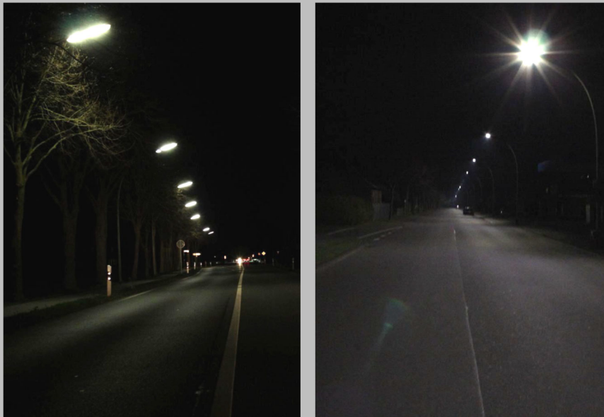
Abbildung 5: ungleichmäßige Beleuchtung vor (links) und gleichmäßige Beleuchtung mit weniger Streulicht nach (rechts) einer Sanierung 13
