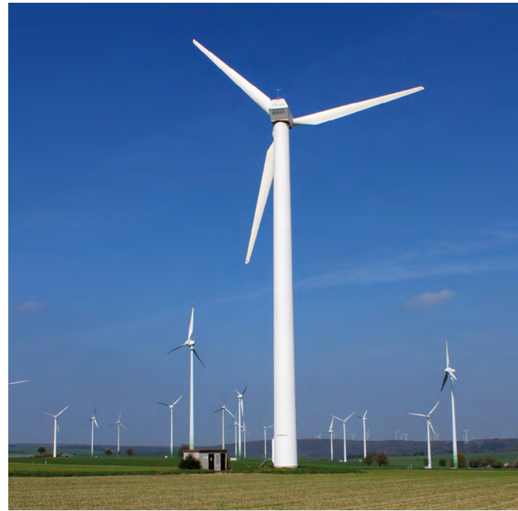
Windenergieanlagen in Lichtenau im Kreis Paderborn.
