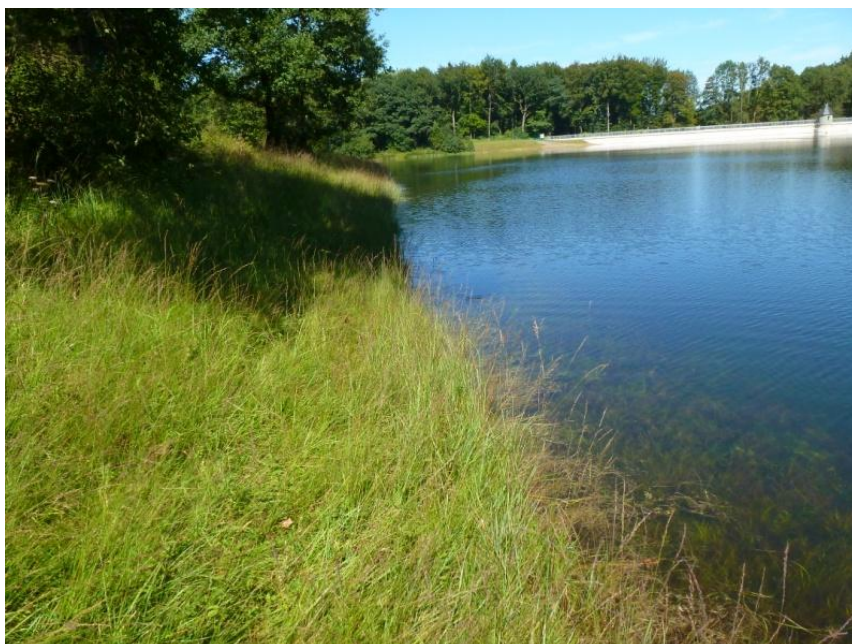
Abbildung 59: Die Panzertalsperre nach dem im Frühjahr 2016 abgeschlossenen Wiederanstau. Der im Vordergrund rechts erkennbare schmale überflutete Vegetationsstreifen sollte zukünftig im Bereich einer Wechselwasserzone liegen, die im Spätsommer und Herbst trocken liegt.
