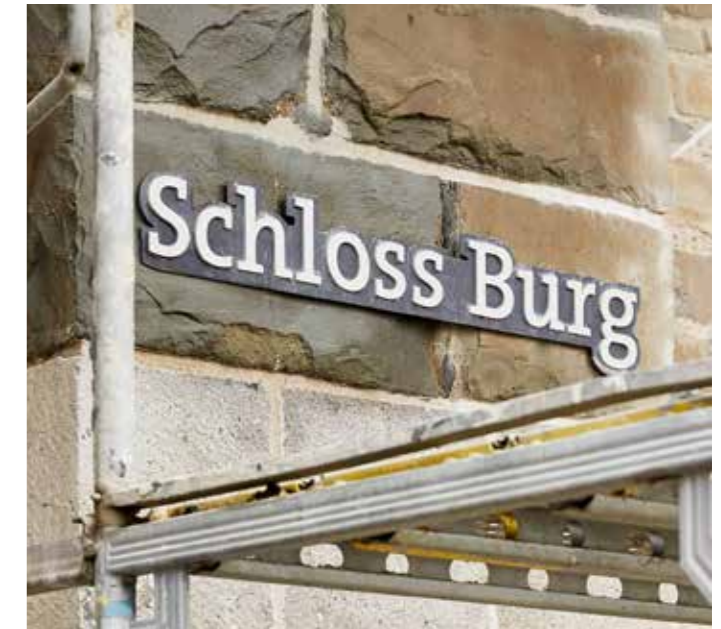
36 Auf Schloss Burg laufen umfangreiche Erneuerungsarbeiten.
