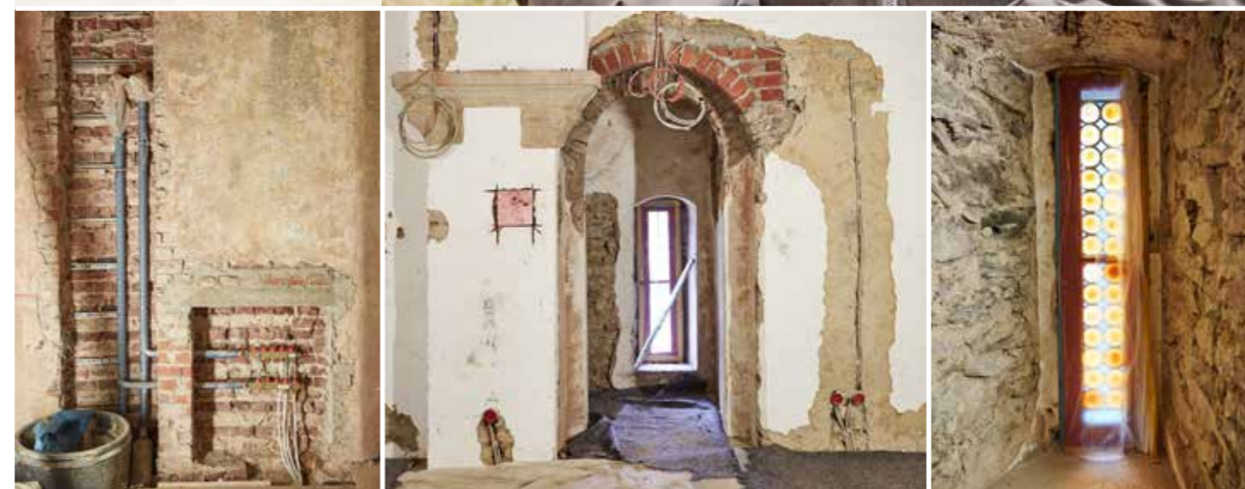
Gregor Ahlmann vom Schlossbauverein Burg freut sich auf die Eröffnung der neugestalteten Räume des bergischen Wahrzeichens im Sommer. Noch laufen die Arbeiten auf Hochtouren.
