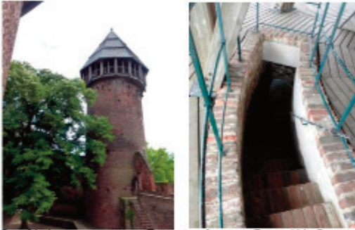
Burgfried Treppenaufgang Fotos: Udo Brauner
