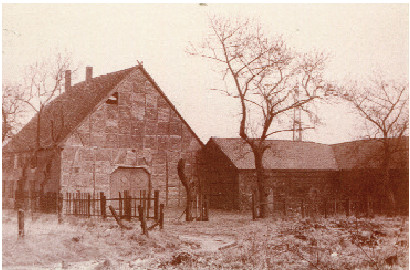
Ansicht des Bauernhofes Barkhof von Süden in den 1960 er Jahren Originalfoto von Hugo Rieth
