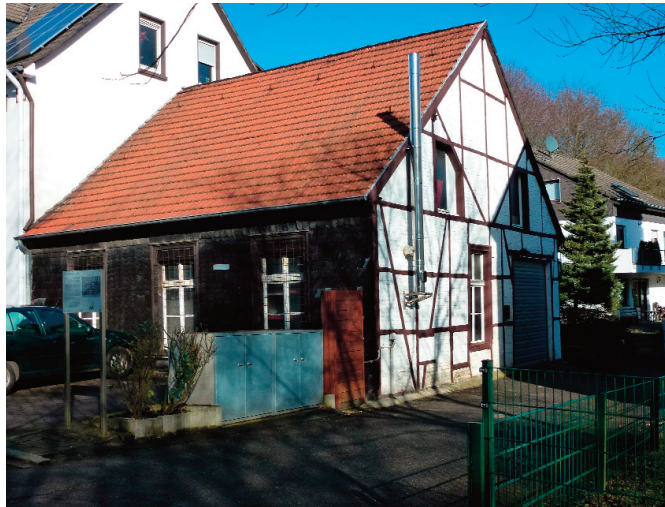
Das ehemalige Schulhaus im Jahr 2000
