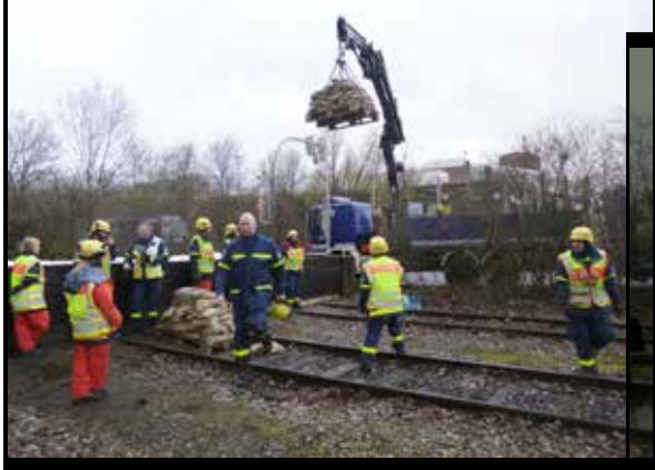
18. März: In Kooperation mit dem Technischen Hilfswerks fand jetzt eine Hochwasserschutzübung des Tiefbaumanagements der Stadt Neuss statt
