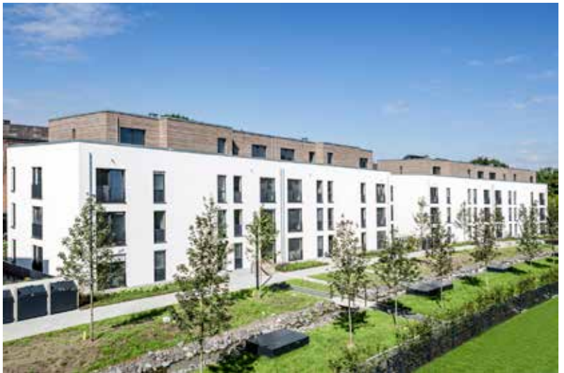
Neues Quartier Hülchrather Straße
