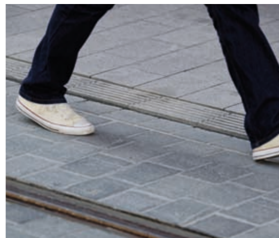
Auf dem neuen Natursteinpflaster können die Passanten nun entspannt bummeln.
