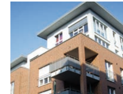
Wohngebäude an der Salzstraße
