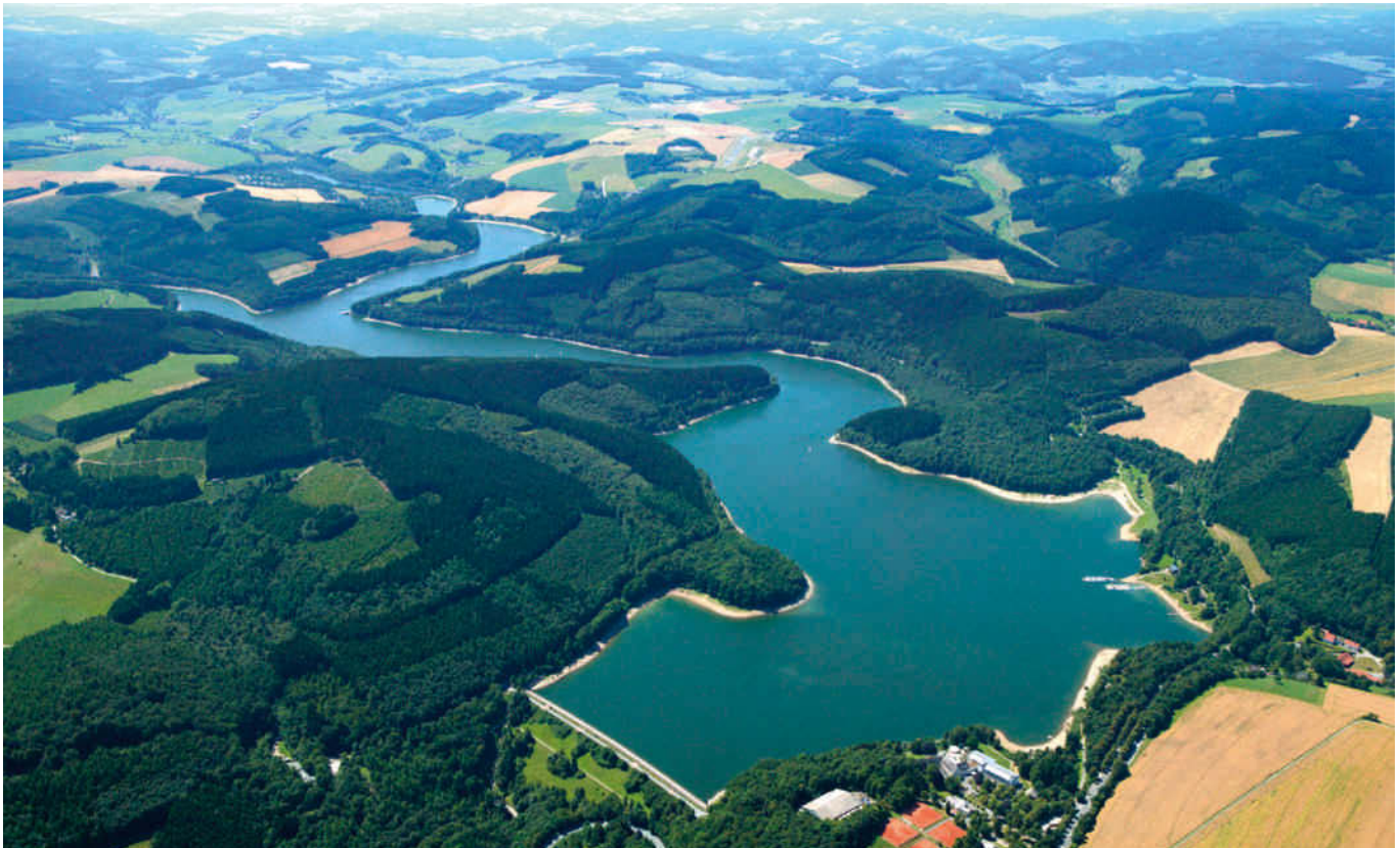
Bild 6.3: Luftaufnahme der Hennetalsperre Fig. 6.3: Aerial view of the Henne Reservoir
