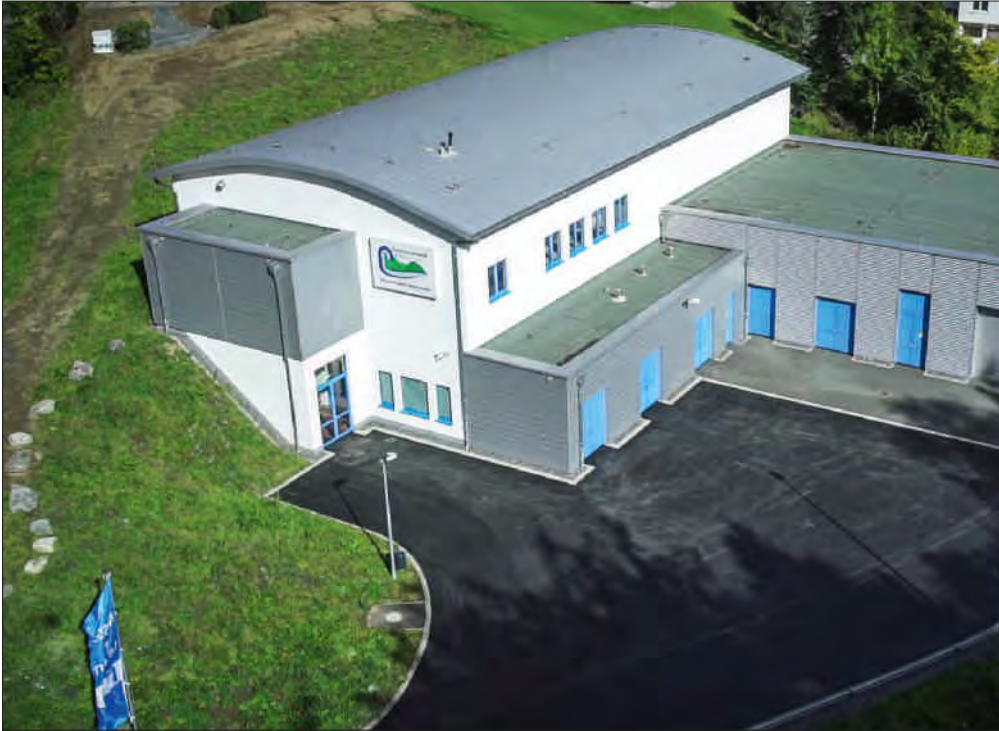
Bild 16.4: Fertiggestelltes WW Hennesee Fig. 16.4: Completed waterworks Lake Henne
