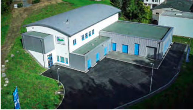
Bild 6.4: Bild des Wasserwerks Hennetalsperre (Foto: Hochsauerlandwasser) Fig. 6.4: Picture of the Henne Reservoir waterworks (photo: Hochsauerlandwasser)
