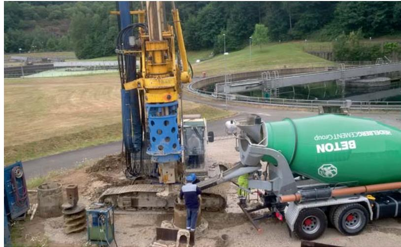
Kläranlage Buchenhofen: Ein Pfahl für die Gründung wird betoniert.
