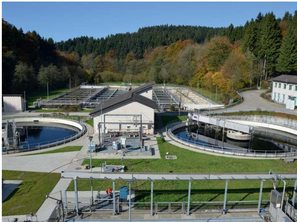
Bei der Sanierung der Kläranlage Burg hat der Wupperverband seit dem Projektstart 2013 bereits das BHKW und die Schlammeindickung erneuert sowie die Nachklärbecken optimiert. Seit Herbst 2016 laufen der Umbau des Wasserwegs und die Erneuerung der elektronischen Mess-, Steuer- und Regeltechnik. Die Belebungsbecken erhalten ein neues Belüftungssystem. Im Frühjahr 2018 soll das umfangreiche Projekt abgeschlossen werden.
