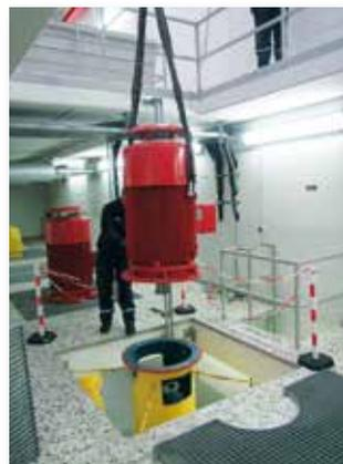
Ende Mai wurde im Pumpensumpf des **SCHMUTZWASSERPUMPWERKS KAPELLENSTRASSE** in Monheim ein defekter Absperrschieber DN 500 an einer der vier installierten Pumpen demontiert und ein neuer Absperrschieber eingebaut. Gleichzeitig wurde die Gelegenheit genutzt, um den Pumpensumpf gründlich zu reinigen.
