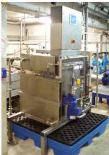
Aufgrund starker Vibrationen wurde eine der drei Überschussschlammzentrifugen des **KLÄRWERKS SOLINGEN-OHLIGS** neu gelagert. Nach Wiederinbetriebnahme zeigten sich weiterhin erhebliche Schwingungen, weshalb Trommel und Schnecke der Zentrifuge zum Wuchten ins Herstellerwerk gebracht wurden. Parallel dazu wurde der Frequenzumrichter der Beschickerpumpe ausgetauscht. Durch diese beiden Maßnahmen konnten die Schwingungen endgültig beseitigt werden.
