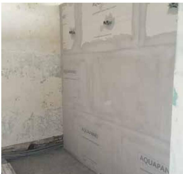
Der Trockenbauer/Fliesenleger verkleidete das Gis-system mit Rigips, verputzte die Wände und begann mit den Fliesenarbeiten. Parallel dazu begannen die Elektriker ihre Leitungen für die neuen Lampen, Steckdosen und dem neuen Lüftungssystem zu verlegen.
