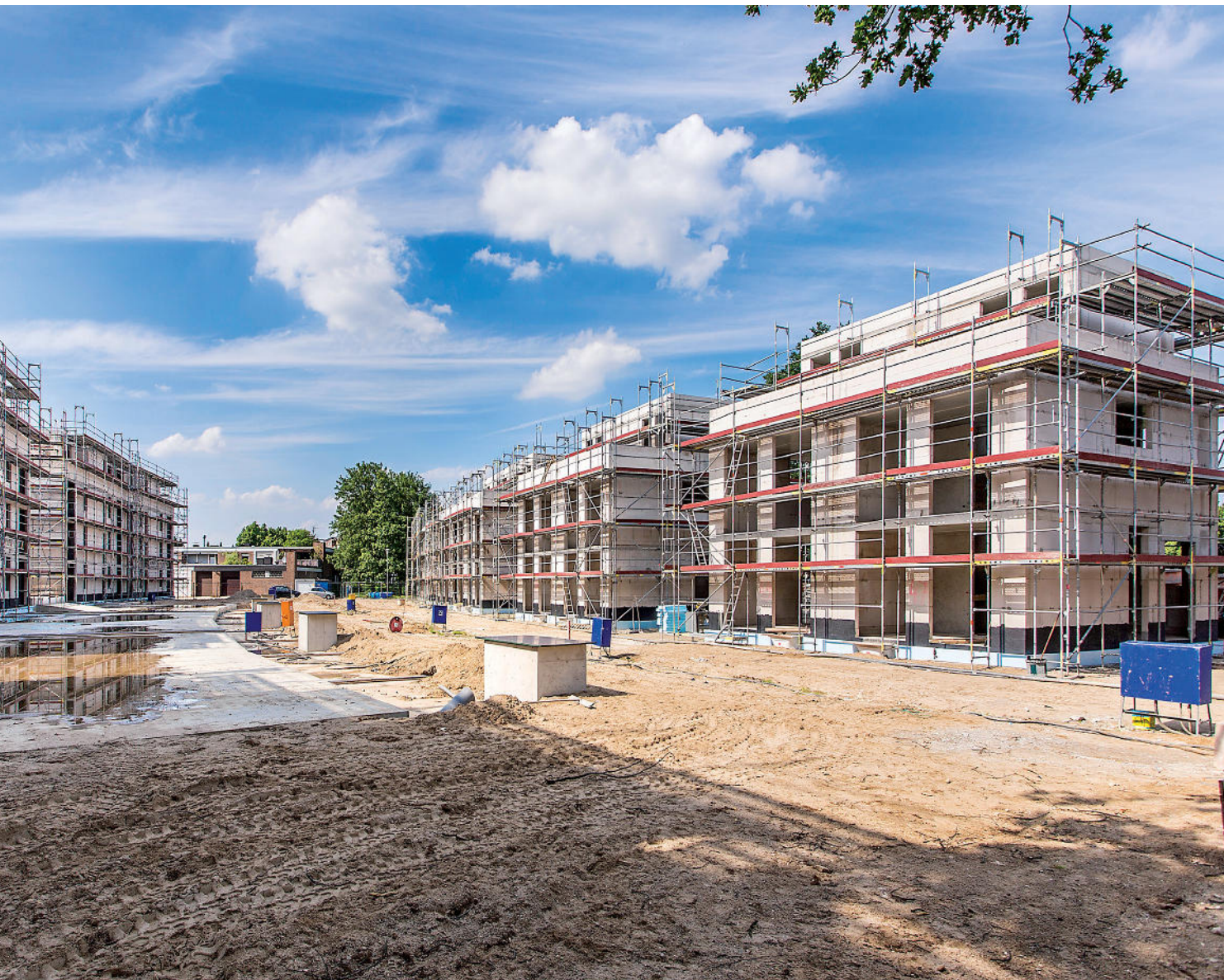
Ein neues Wohnquartier steckt an der Hülchrather Straße in Weckhoven bereits in der Umsetzung. Hier werden 198 Mietwohnungen und 22 Einfamilienhäuser geschaffen.
