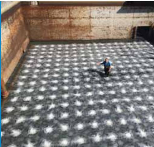
Funktionskontrolle der Belüftung beim Blasentest
