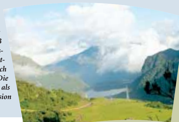
Pipelinetrasse entlang einer Trinkwasserlagune in Ecuador.
