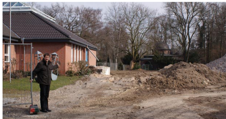
Heimleiter Thorsten Stockhausen erläutert die Baustelle vor seiner „Haustür“: Das alte Bettenhaus wurde abgerissen, die Sicht auf die Ukrainische Kapelle im Hintergrund ist frei.
